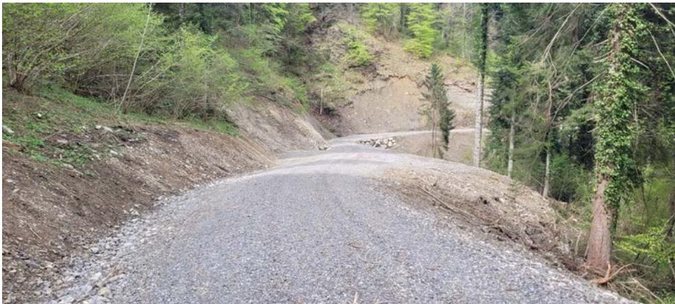
*Figura 3: esempio di canale a monte realizzato in seguito alla sagomatura del piano stradale a dorso di mulo*
