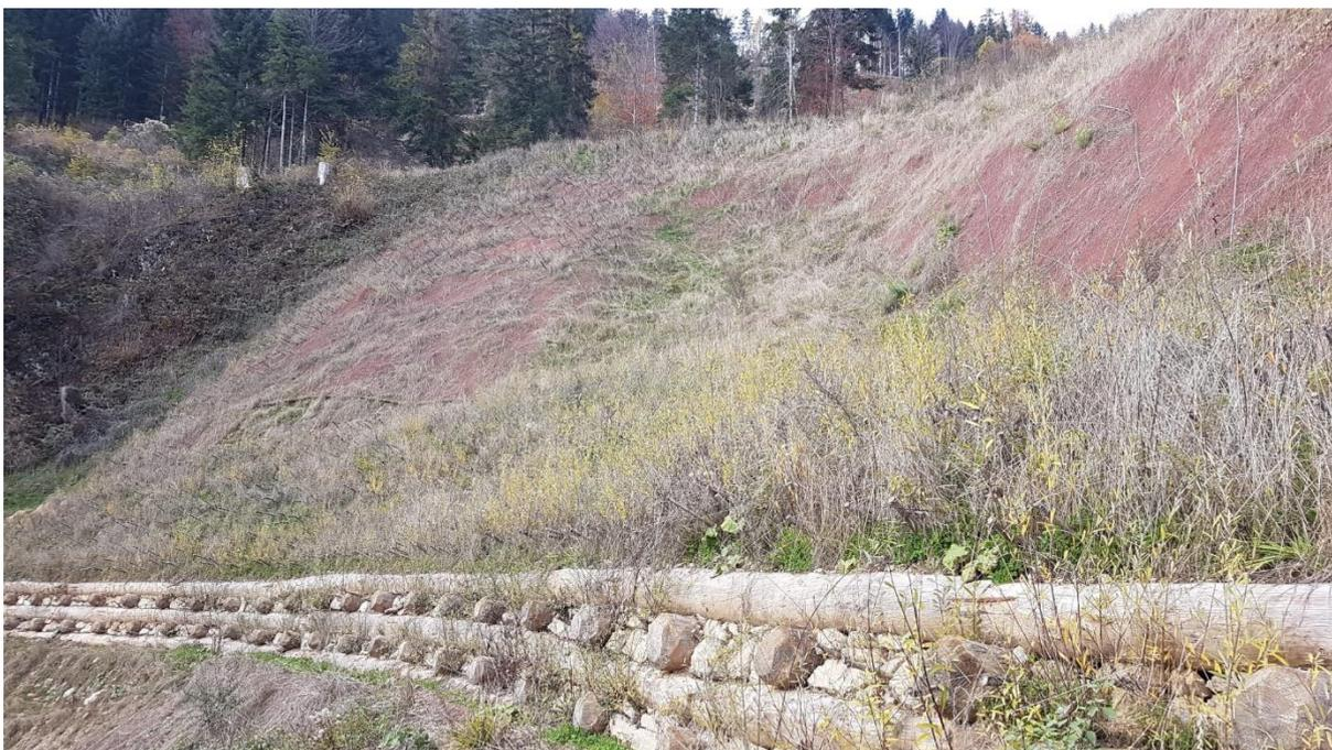
*Figura 5: esempio di sistema antierosivo con geocomposito e talee*
