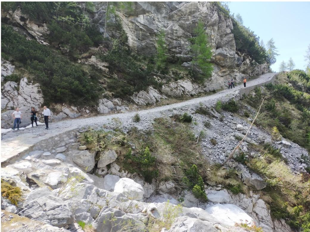
Tratto fra sez. 13 e sez. 14. Rampa (corazzatura) e ricostruzione opera sostegno al rilevato (scogliera in grossi massi)
